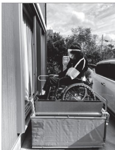
図2 リビング窓に設置した車椅子用昇降機
