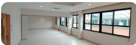
改修を終えたばかりの園舎。保育室と乳児室を仕切るアコーディオンカーテンは用途に応じて開閉可能
